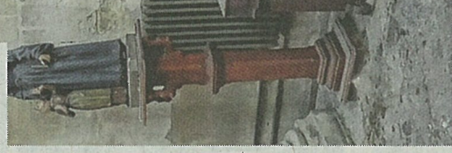
La chapelle se trouve à l'angle des rues Prévost et de l'Ancien Temple. Le pilier central (à droite sur la photo ci-dessous) s'est enfoncé dans le sol, déséquilibrant le bâti.
